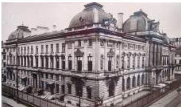
Дворец Национального Банка. Здание построено по проекту французских архитекторов А. Галерона и К. Бернарда
